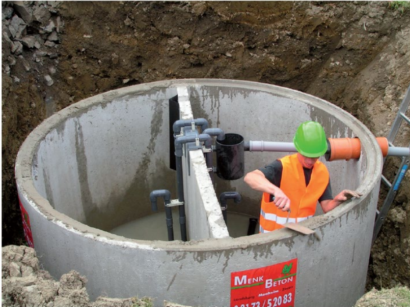
Abbildung 6: Aufbringung Mörtel (vollfugig)
