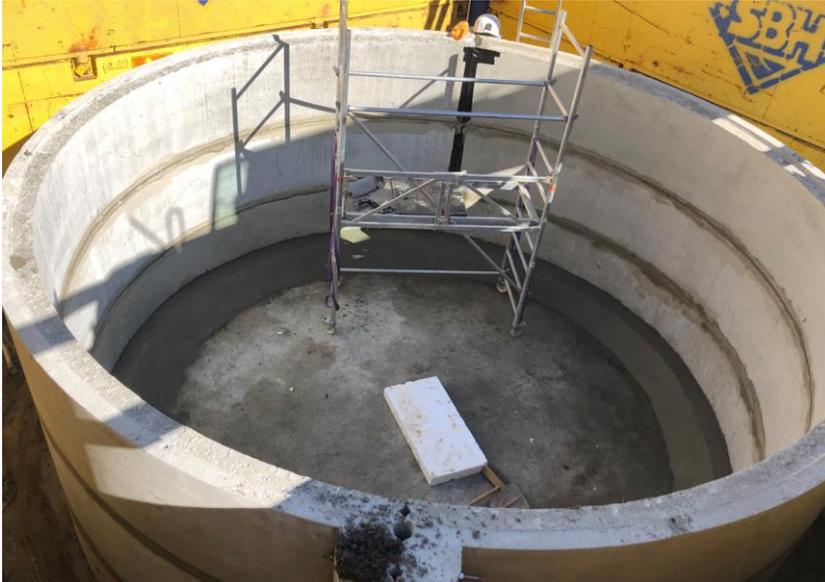
Anbringen eines Dichtbandes vor dem Ausgießen der Schlösser:
